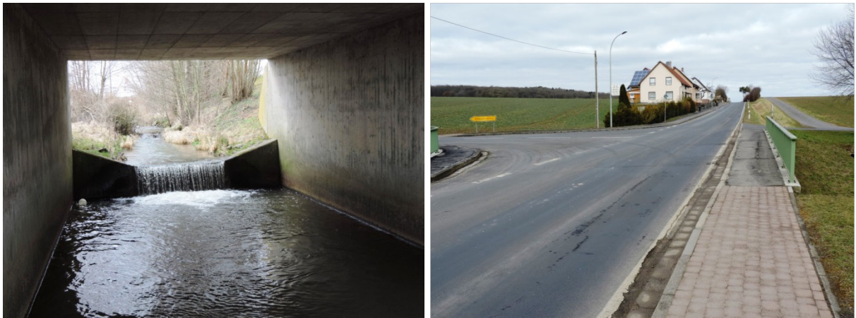
Abb. 33: Links - eine Sohlschwelle unter einer Brücke über den Erlenbach bei Münch-Leusel zwingt Otter über die dort besonders gefährliche Straße L3156 zu laufen; rechtes Bild: der Verlauf der L3156 im Bereich der Brücke über den Erlenbach – das Risiko einer Kollision zwischen Fischotter und KFZ ist hier besonders hoch.
