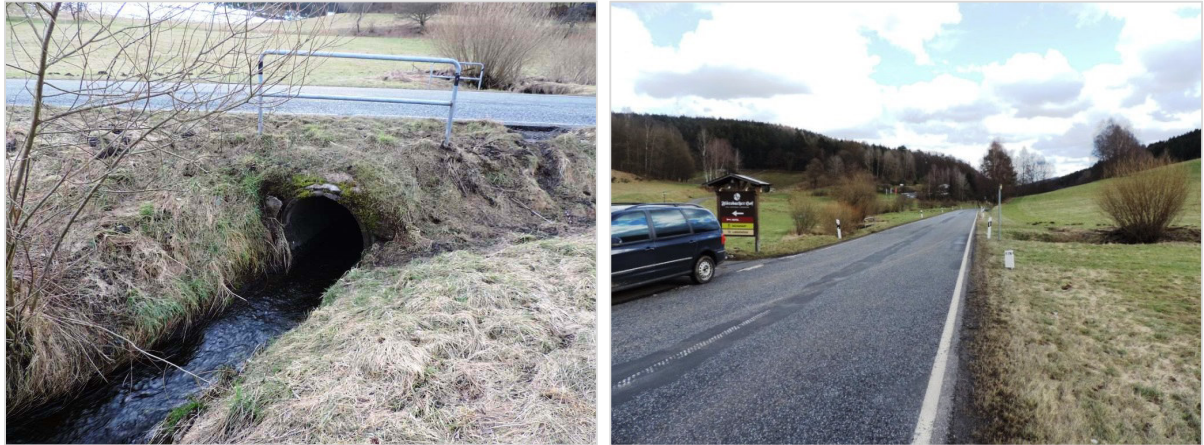
Abb. 35: Gefahrenpunkt Flörsbach-G01 am Oberlauf des Flörsbach. Fischotter meiden solche Durchlässe in aller Regel und umgehen sie; dabei geraten sie auf die Fahrbahn und sind einem erheblichen Kollisionsrisiko ausgesetzt. Der oberste Oberlauf des Flörsbach wird von Ottern insbesondere dann genutzt, wenn diese über die naheliegende Wasserscheide in das Einzugsgebiet der Bieber/Kinzig wandern wollen.
